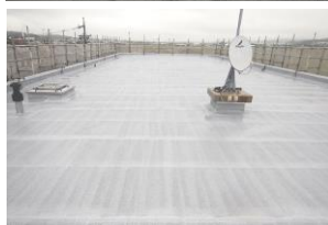
↑ 屋上アスファルト防水
