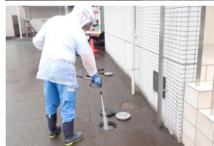
↑ 共用部排水管洗浄
