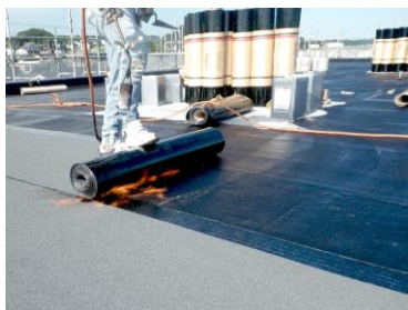
↑ 屋上アスファルトシート防水
