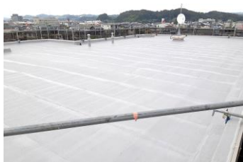
↑屋上アスファルト防水
