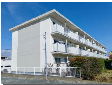
↑外壁改修完了
