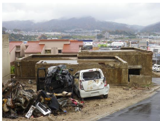
【県営住宅隣の集会所(鉄筋コンクリート造)】
