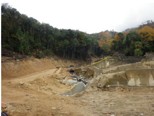
【土砂崩れのあった現場】
