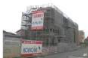
浜松市東区建設現場
